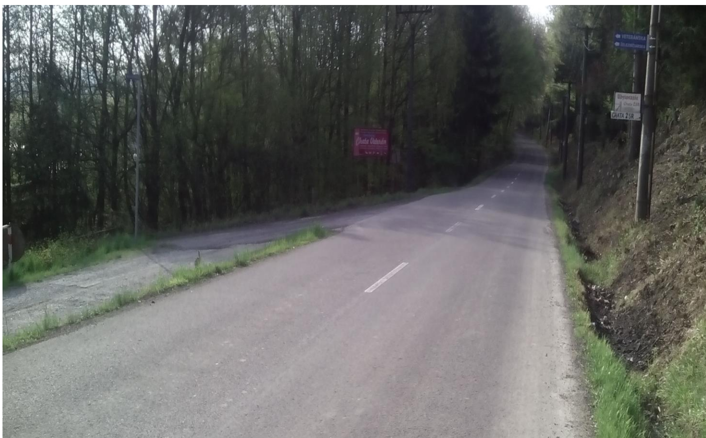
Foto č. 19 – Snímanie kamerou č.19 – Vstup do rekreačnej oblasti z obce Malá Domaša
