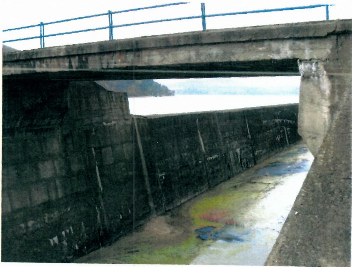
Obr. 3.2 – vnútorná strana zberného žľabu a priepadovej hrany BP nádrže V.Domaša
