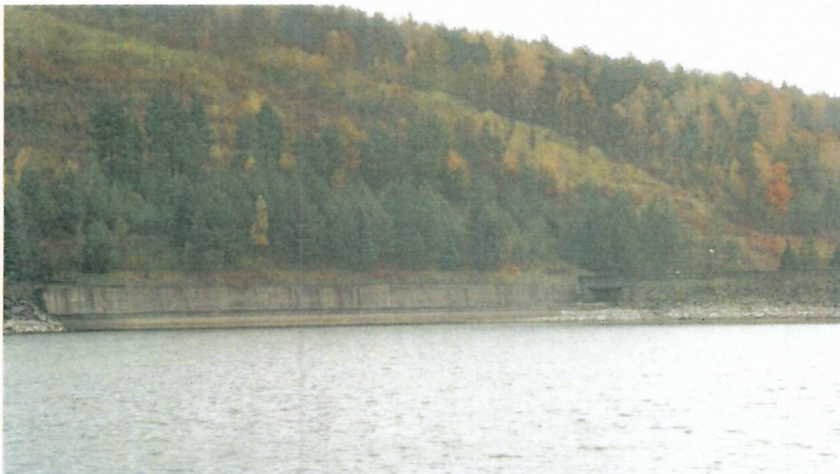
Obr.3.1 – bezpečnostný priepad nádrže V.Domaša pri hladine na úrovni 159,45 m Bpv
